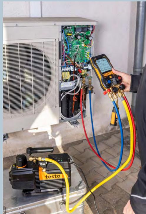
kabelloser Vakuumsonde und Zangen-Temperaturfühlern.
