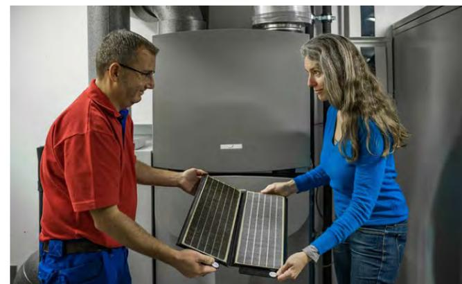
Nach Anleitung übernimmt der Betreiber den einfachen Filterwechsel selbst. Komplexere Wartungsarbeiten und die Reinigung des Kanalnetzes sollten hingegen in einem Wartungsvertrag festgehalten werden. (Quelle: ZVSHK)
